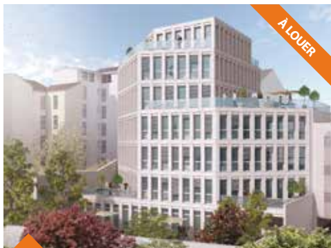
Le Béranger – Lyon 6 e Immeuble tertiaire de 2 247 m 2 de bureaux sur 5 étages et un attique, au cœur du 6 e arrdt de Lyon
